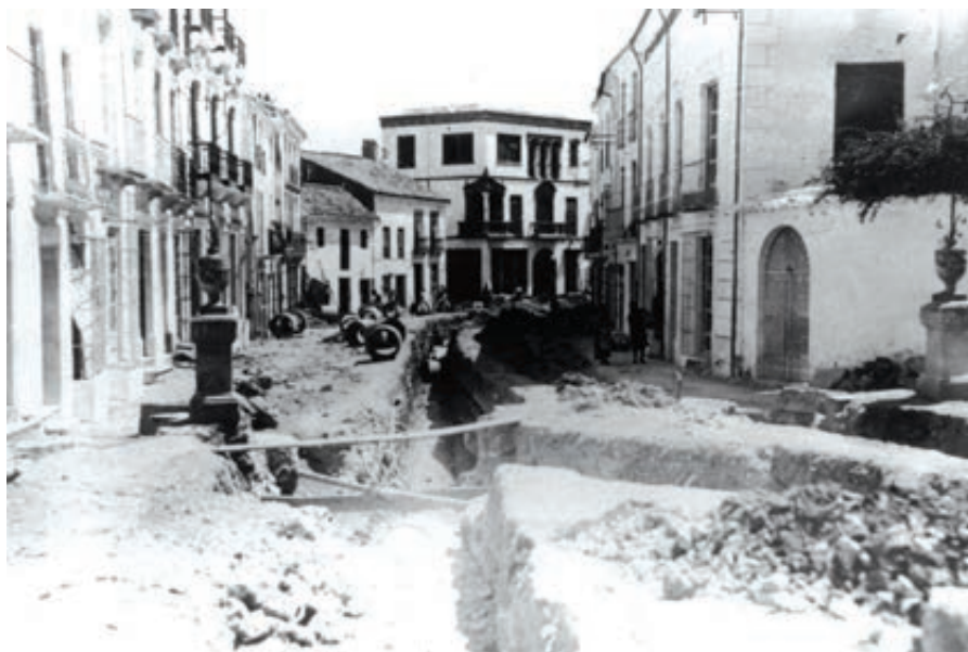
Ilustración 7. Canalización de las aguas en la calle Río.
